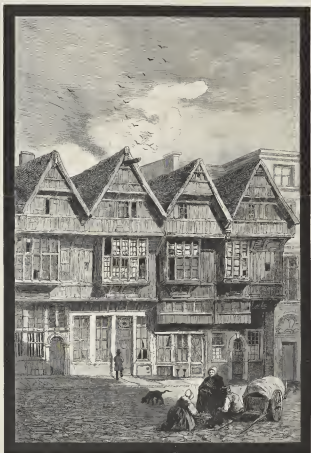
Façades en bois de Maisons du XV e siècle.
